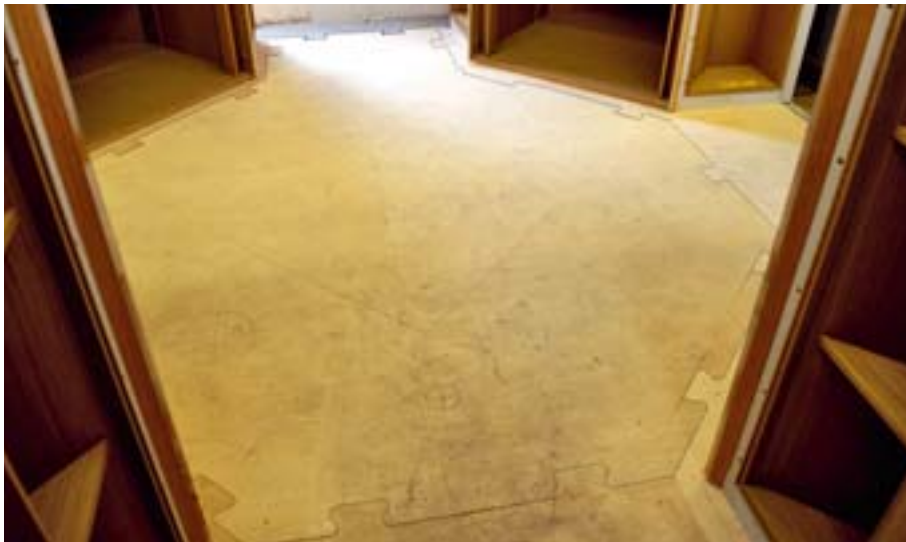
Montagehilfe: An dem Bodenpuzzle lassen sich Einrichtungen exakt und flink positionieren
